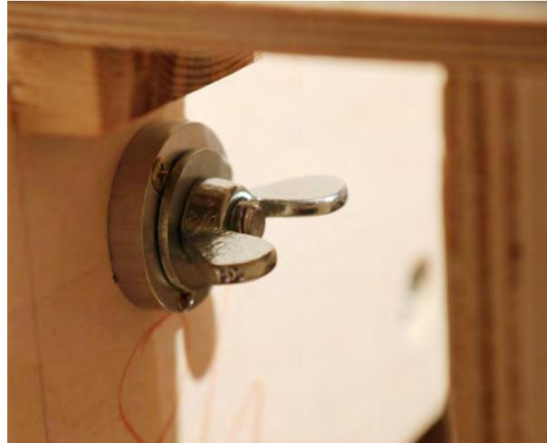
Bild links: Die 4,5 x 4,5 cm starken Stützen werden in einfache Halterungen aus Holz eingesteckt und mit einer Flügelschraube fixiert.
