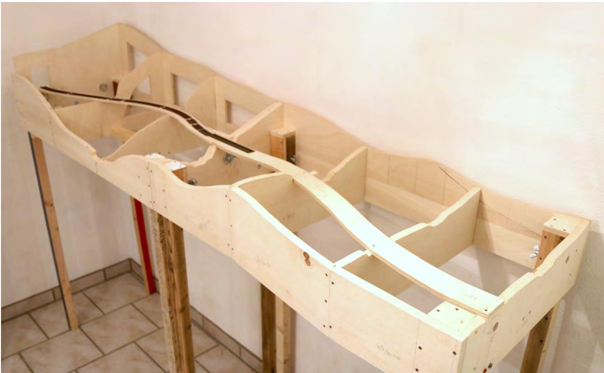
Die grobe Form des Geländes ist bereits durch die Holzkonstruktion vorgegeben. Mit Styrodur, gelegentlich auch Styropor und puren® MODUR Modellbauhartschaum-Platten fülle ich die Zwischenräume zwischen den Spanten auf.
